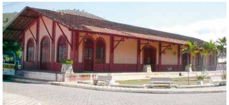
Estação Ferroviária de Lavrinhas
